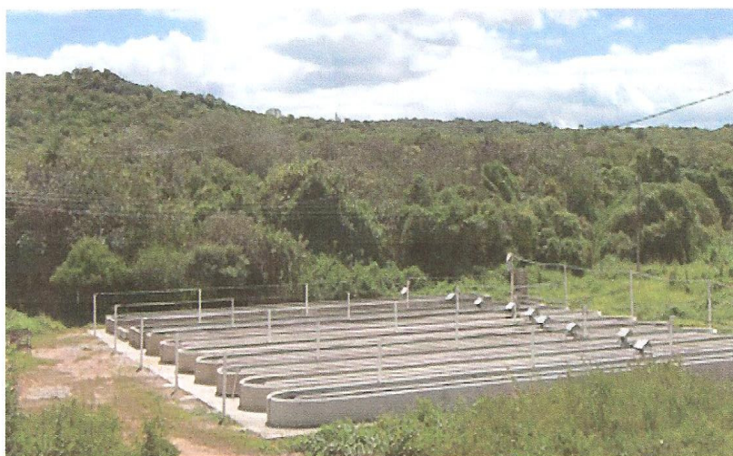
Planta piloto para produção de espirulina platensis. A planta conta com 10 unidades de produção (tanques) e tem capacidade para 150.000 Litros. Foto: Divulgação
